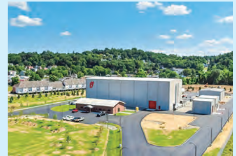
クライオポンプ試験施設外観
